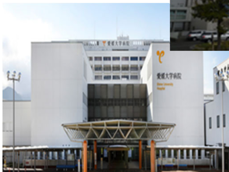
既存建物外観
