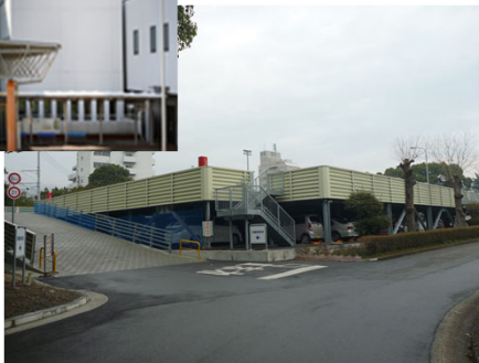
既存建物外観
