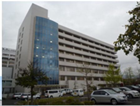
既存建物外観
