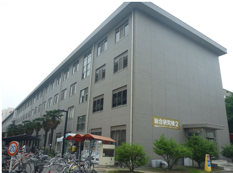
既存建物外観
