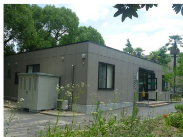
建物外観：取壊し前
