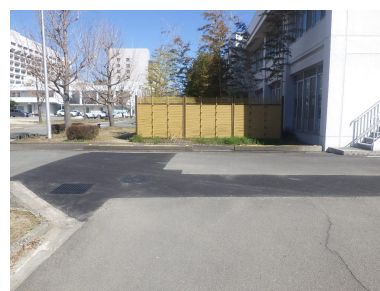
医学部コミュニティハウス 北側 屋外排水管
