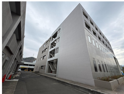
建物外観（西側）
