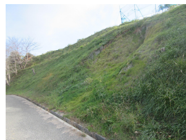
北条団地（法面(復旧後)）
