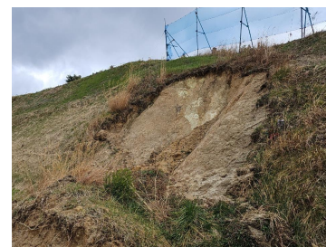
北条団地（法面(被災時)）
