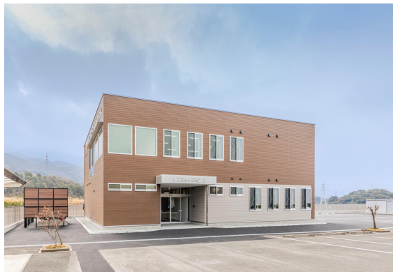
建物外観：紙産業イノベーションセンターB棟 (仮称) 【完成】
