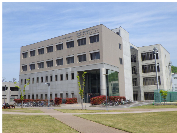
建物外観 総合情報メディアセンター
