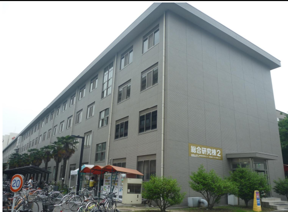
建物外観 社会共創学部本館/総合研究棟 2
