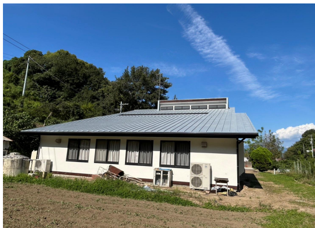
建物外観（西側）
