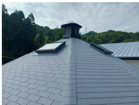
建物外観（屋根）
