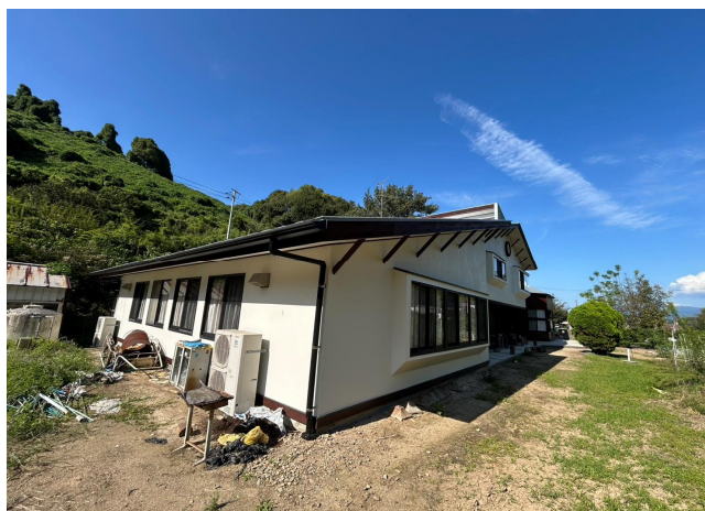
建物外観（南西側）
